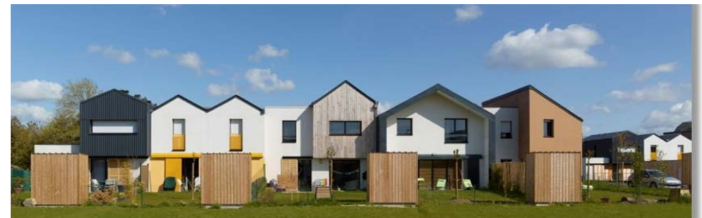
Opération groupée « Vert Buisson » à Bruz (35)
