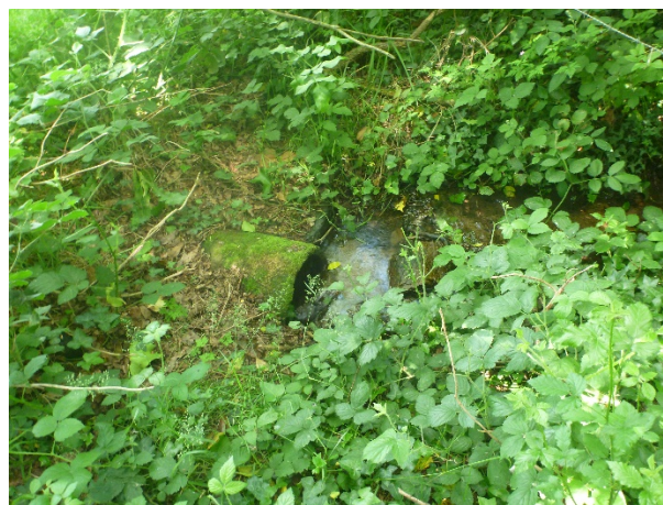
Photo 2 Cours d'eau ajouté au niveau de « Le Mené »
